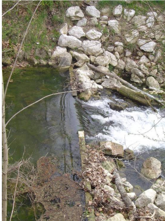
Figure 1 : Exemple de seuil à échancrure au droit d'une station hydrométrique sur le Lamboulas (affluent du Tard, département du Tarn-et-Garonne)
